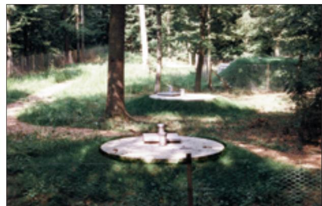
*Sickerschlitzgraben und Einzelbohrungen zur Infiltration*
